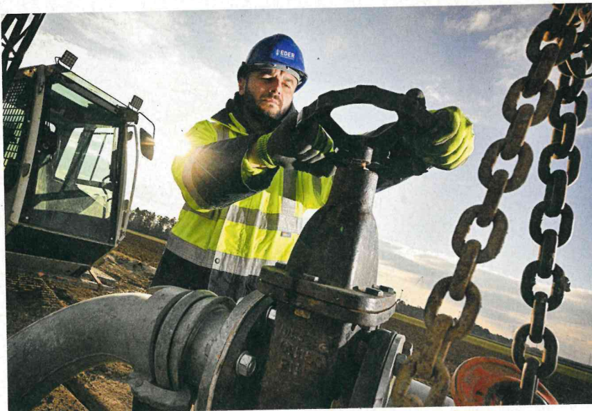
Eder Brunnenbau: Mit Erfahrung und moderner Technik zuverlässig und präzise bis ins Detail.
